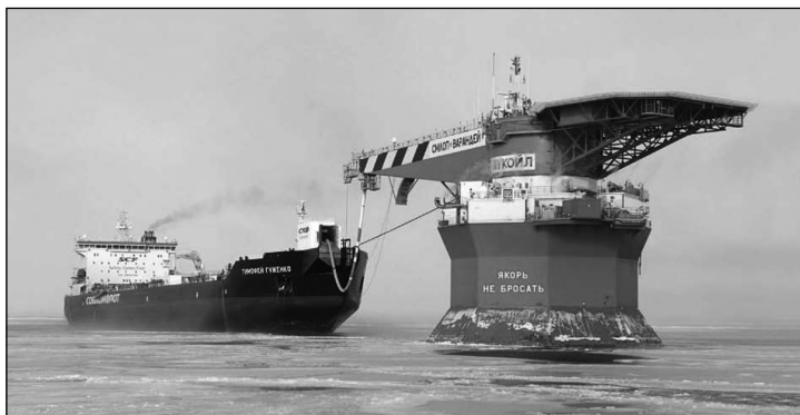
Рис. 20. Стационарный морской ледостойкий отгрузочный причал «Варандей» и танкер «Тимофей Гуженко» (фото Aker Arctic )
